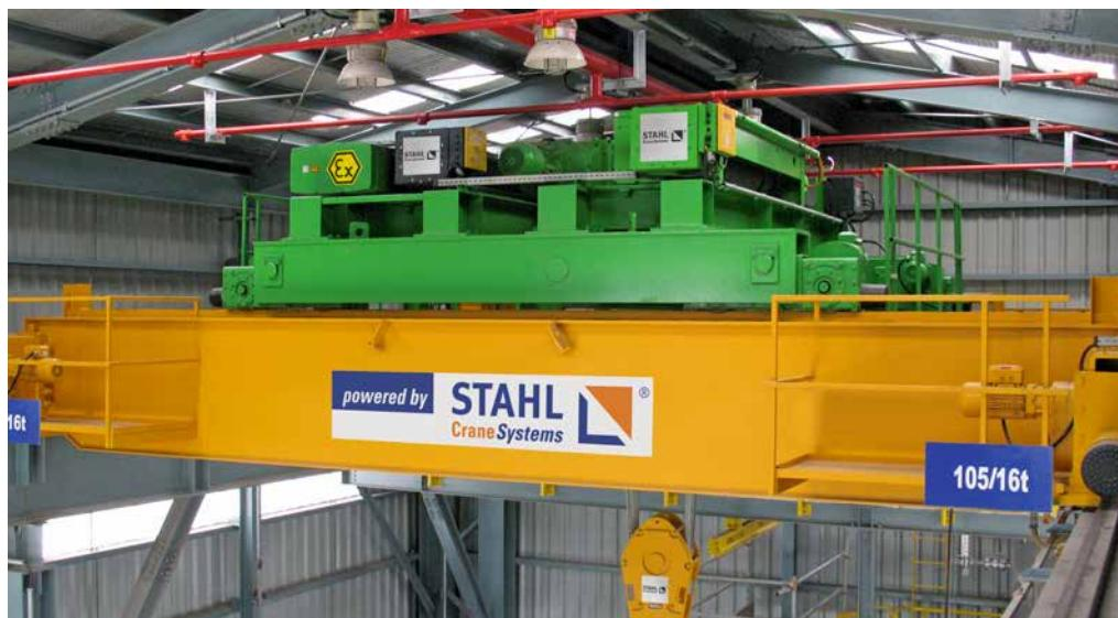
Des palans à câble anti-déflagrants en exécution jumelée avec levage auxiliaire facilitent la maintenance des compresseurs dans une installation de liquéfaction d'hydrogène.
