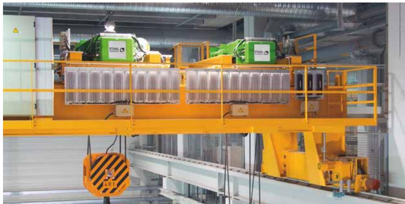
Ces palans à câble AS 7 sont équipés de plates-formes de maintenance qui sécurisent les travaux d'inspection. Les crochets doubles des moulfles peuvent être pivotés électriquement pour la manutention avec une grande sensibilité.
